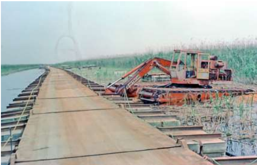
تصویر ۲. نمایی از مراحل انتهایی ساخت پل خیبر
