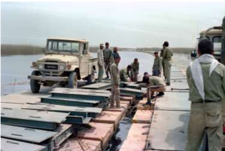
تصویر ۱۵. نمایی از نصب پل خیبر
