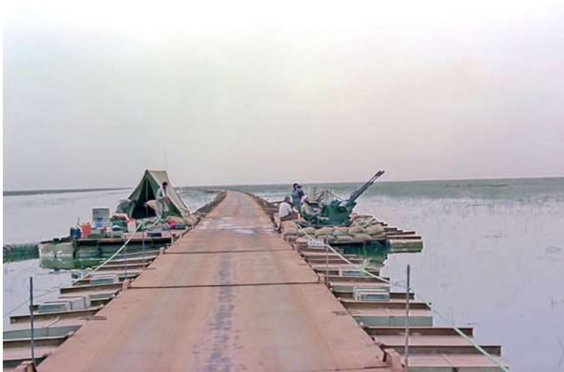
تصویر ۴. استقرار پدافند هوایی روی پل خیبر
