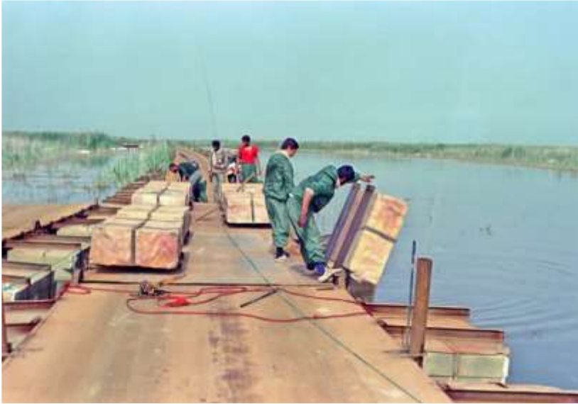
تصویر ۱. نمایی از نصب قطعات پیش‌ساخته پل خیبر
