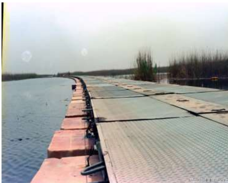
تصویر ۱۶. نمایی از پل خیبر
