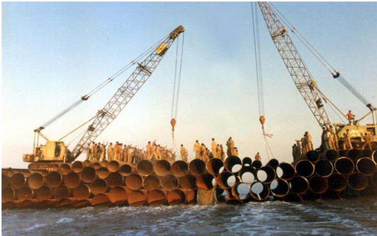
تصویر ۴. مراحل پایانی ساخت پل بعثت (بنی‌هاشمی، ۱۳۸۹) (برگرفته از پایگاه اینترنتی خبرگزاری دفاع مقدس)
