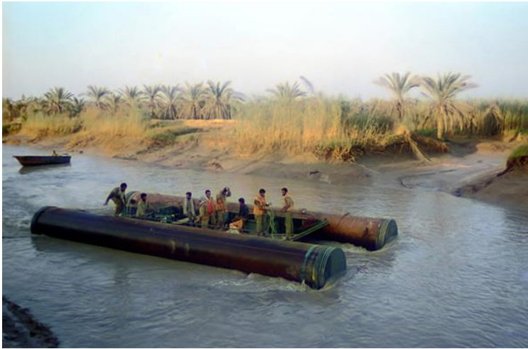
تصویر ۳. انتقال لوله‌ها به اروند با استفاده از شناور روتورگ (بنی‌هاشمی، ۱۳۸۹) (برگرفته از پایگاه اینترنتی خبرگزاری دفاع مقدس)
